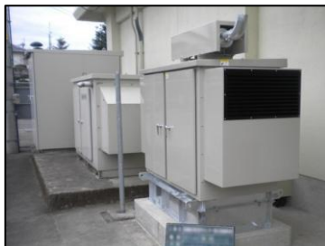
非常用発動発電機設置工事
