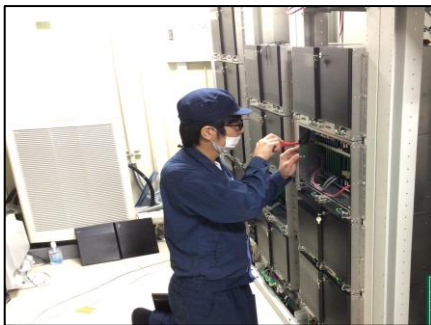
NEC製SV9500交換機新設工事
