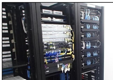
通信機器整備工事
