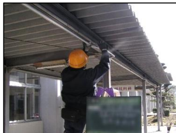
ケーブル配線用配管工事
