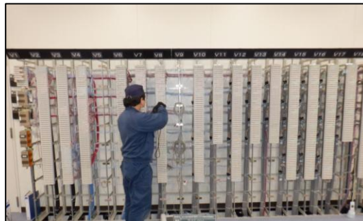
電話ケーブル接続工事
