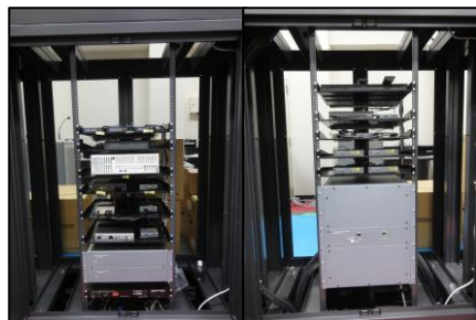
映像制御装置設置工事
