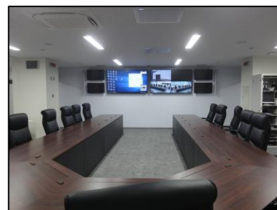
会議室映像・音響設備構築工事
