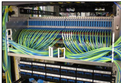
ネットワーク配線工事
