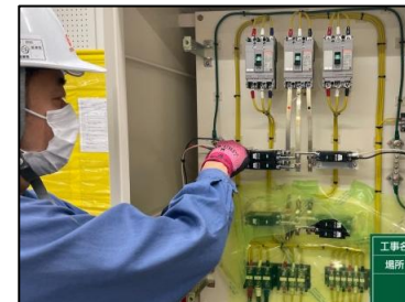
分電盤ケーブル接続
