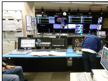
デジタルマスター設備工事
