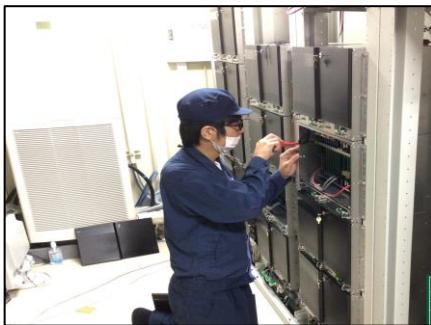
NEC製SV9500交換機新設工事
