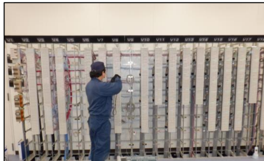
電話ケーブル接続工事
