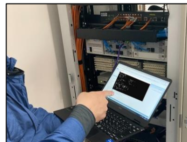
ネットワーク構築工事
