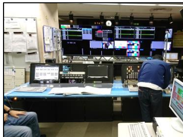
デジタルマスター設備工事
