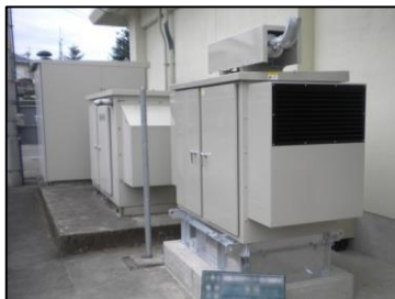
非常用発動発電機設置工事
