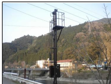
防災カメラ設置工事
