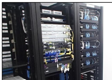
通信機器整備工事
