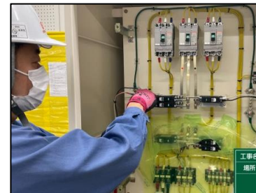
分電盤ケーブル接続
